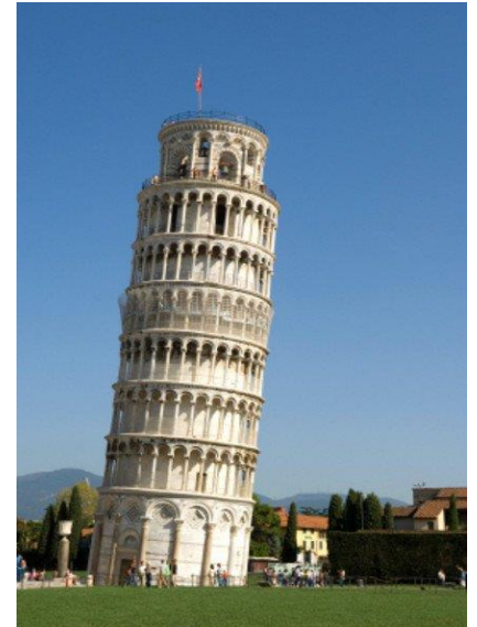
nestabilita a poruchy chůze
